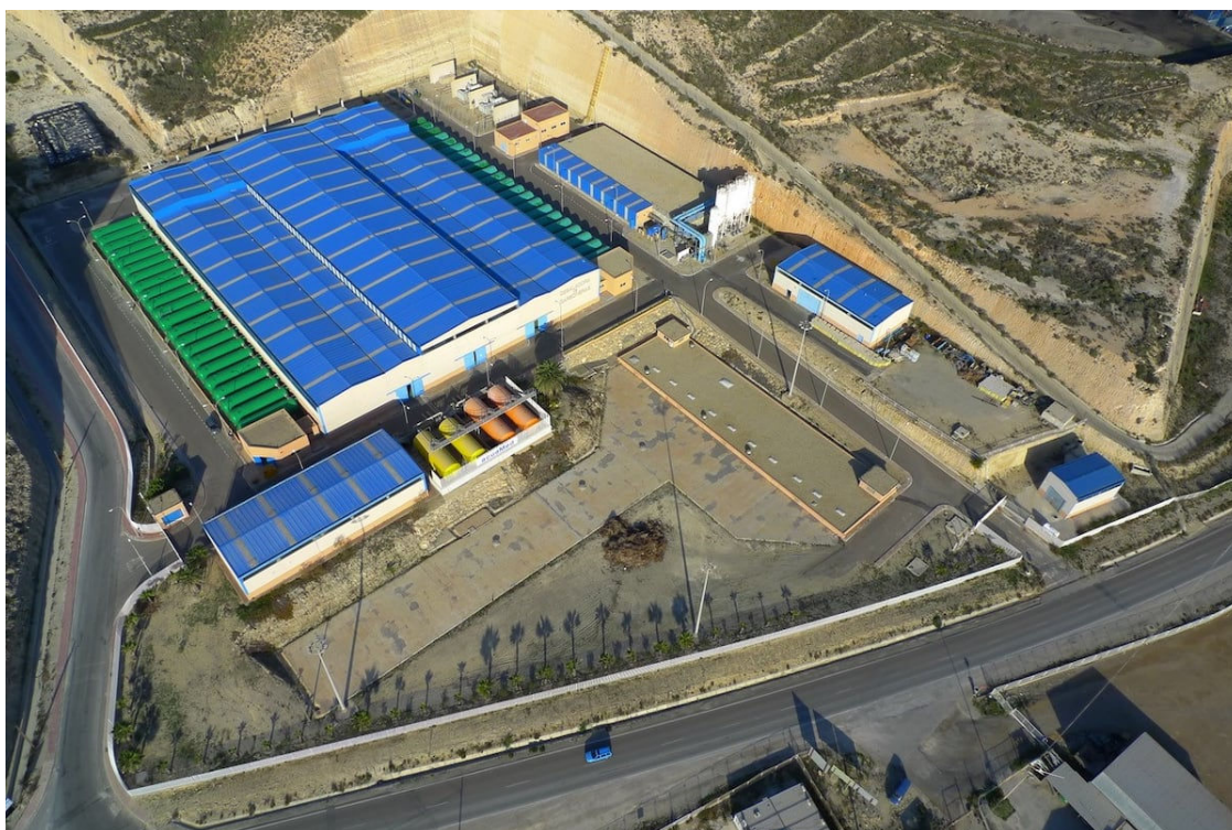
Desaladora de Carboneras (Almería), de GS Inima. FOTO CEDIDA POR INIMA
